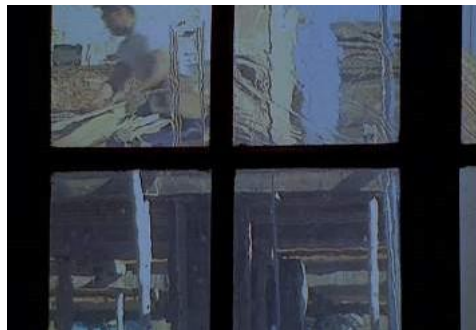
49 – Práce na stavbě z oken bytů sousedů a školy (01:29:23–01:29:57)
