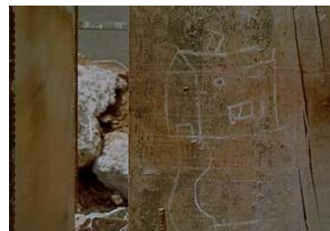
42 – Rozebírání dřevěné stěny s dětskými kresbami na staveništi. Demolice ve čtvrti (01:17:11–01:17:46)
