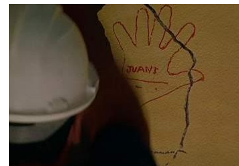
43 – Demolice domu Juani, exteriér a interiér (01:17:46–01:18:04)
