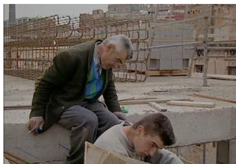
18 – Stavba schodiště a rozhovor mezi Juanem a jeho synem Juanma (00:33:54–00:38:03) [viz analýza v kapitole „Sekvence. Schodiště: práce a předávání znalostí“, s. 22-23]
