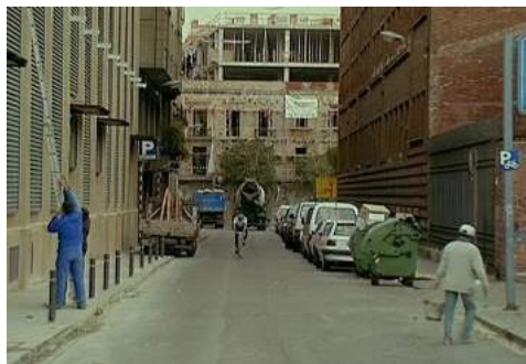
34 – Ulice přilehlé ke staveništi (01:01:31–01:01:58)
