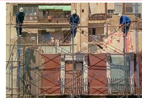
16 – Demolice ve čtvrti a v ulicích (00:32:37–00:33:25)
