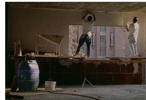
59 - Práce na stavbě: sádrování zdi, malba, dokončování fasád (01:49:29–01:50:25)
