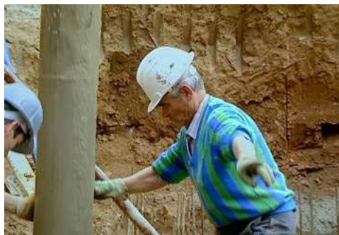
9 – Vrtání děr pro umístění sloupů, kočky a sousedé pozorují práce (Juan), (00:13:31–00:14:27)
