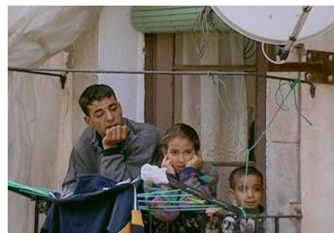
19 – Práce betonářů a Abdel Aziz. Sousedé se dívají z oken (00:38:03– 00:39:22)
