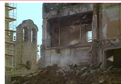
4 – Demolice na staveništi, pohled zvenku a různé interiéry domu (00:07:03–00:07:51)
